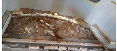
Das schadhafte Holz wurde entfernt und durch neues Holz ersetzt. Darunter wurde zunächst der Fußboden durch Maurerarbeiten geebnet und unter das neue Holz eine Folie gelegt, um das Eindringen von Feuchtigkeit zu verhindern. Während dieser Arbeiten musste der Altar abgestützt werden.
